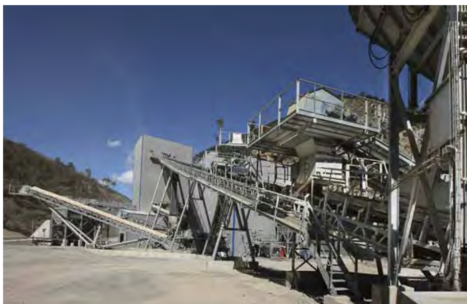
► Les installations de la carrière de granulats de La Courbaisse dans les Alpes-Maritimes
