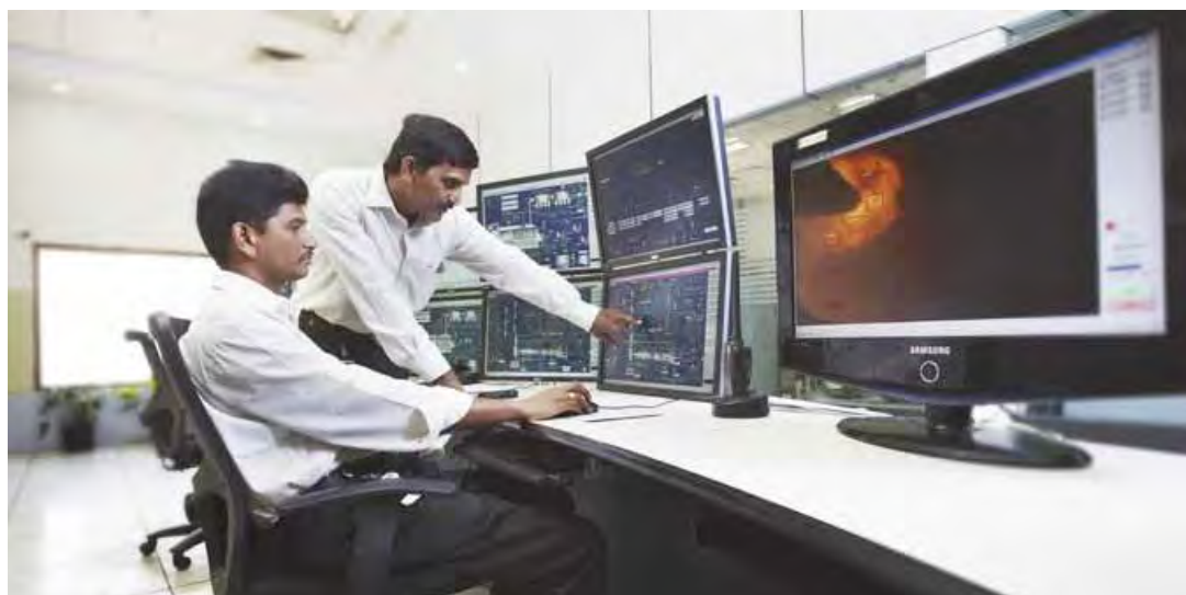
► La salle de commande de l'usine de Bharathi Cement (Inde)
