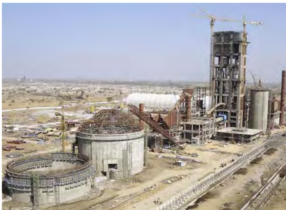
▼ Site de construction de l'usine de Vicat Sagar Cement au Karnataka en mars 2012
