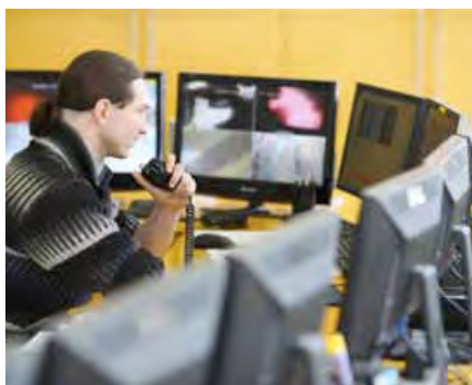
▲ Pupitre dans la salle de contrôle de l'usine de Jambyl Cement
