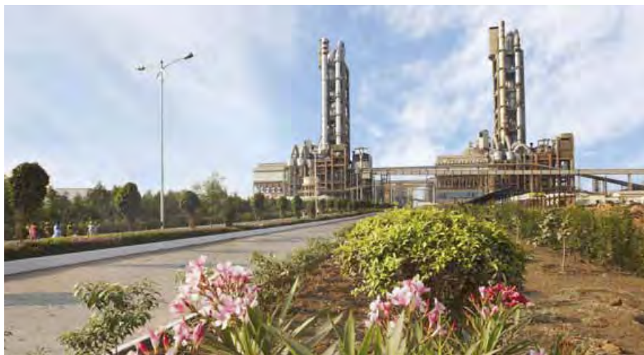
▲ Entrée de l'usine de Bharathi Cement dans l'Andhra Pradesh
