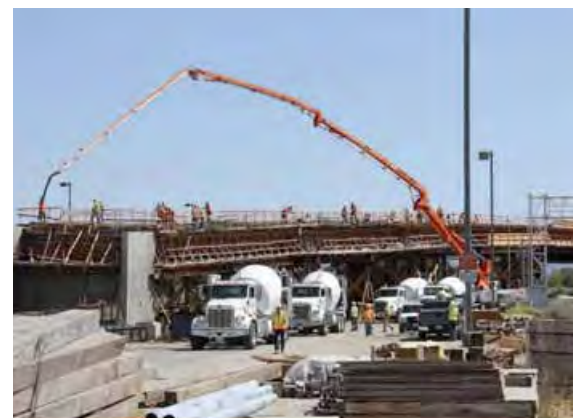
▲ Construction d'un pont au-dessus de la rue Lassen à Chatsworth
