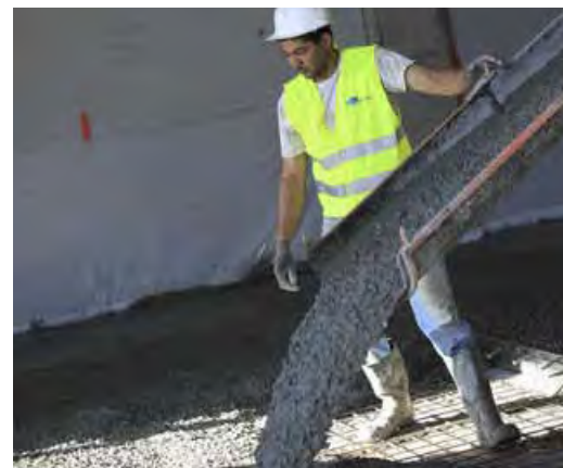
▲ Mise en place d'un béton courant de dallage par l'intermédiaire de la goulotte de déchargement d'un camion malaxeur
