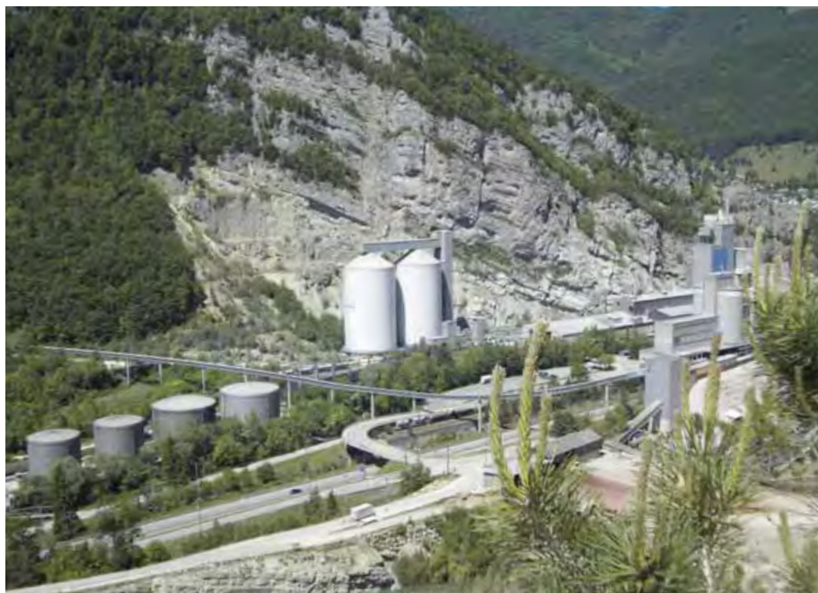
▲ L'usine de Reuchenette
