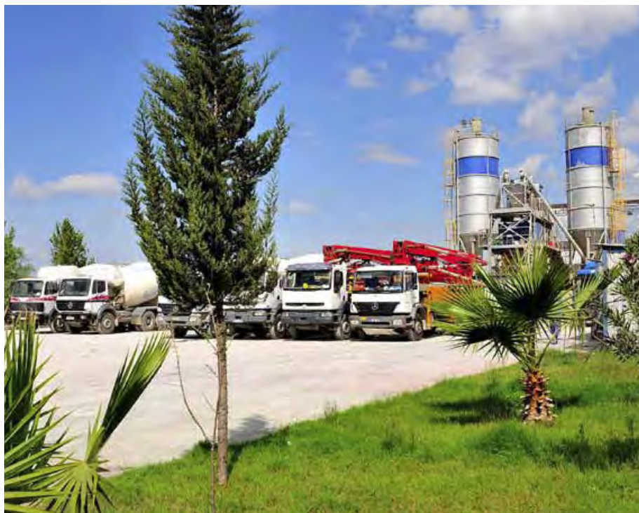
▲ La centrale à béton de Serick
